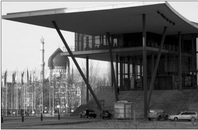
Igralna dvorana 38. šahovske olimpijade.
